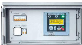
**Контроллер «ЭЛЕКТОН-10.1» позволяет максимально автоматизировать работу насосной установки и оптимизировать процесс добычи нефти.**
